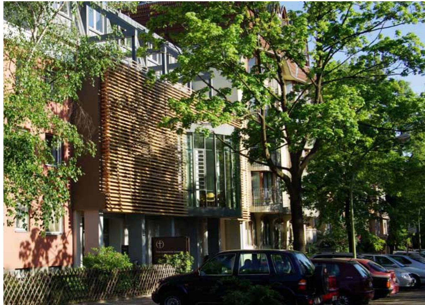
Ansicht Ost, Wenckebachstraße
